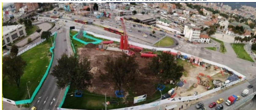
Ilustración 1 Panorámica Preliminares de Obra
