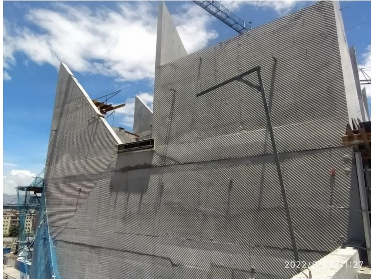
Acabado de concreto sobre fachada costado oriental.
