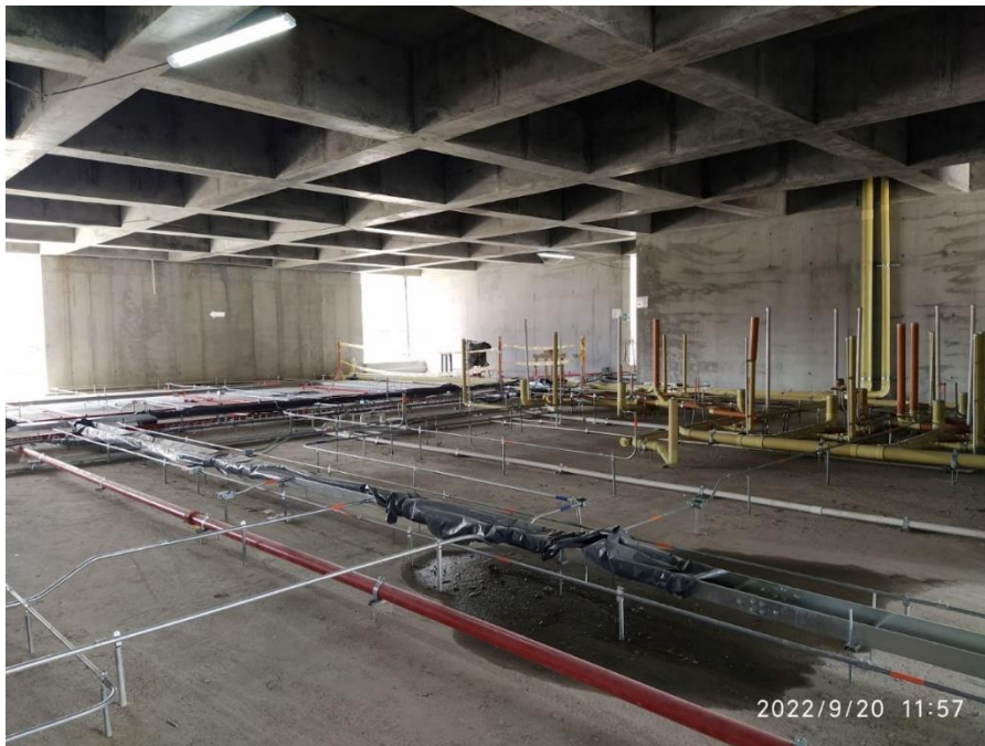
Avance de instalaciones técnicas.
