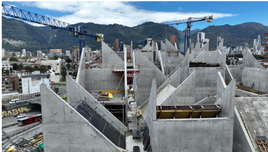
Avance presentado del armado de acero, formaleta y vaciado de concreto para placas inclinadas de los picos de cubierta. Fuente: Pacheco Estudio de Arquitectura.
