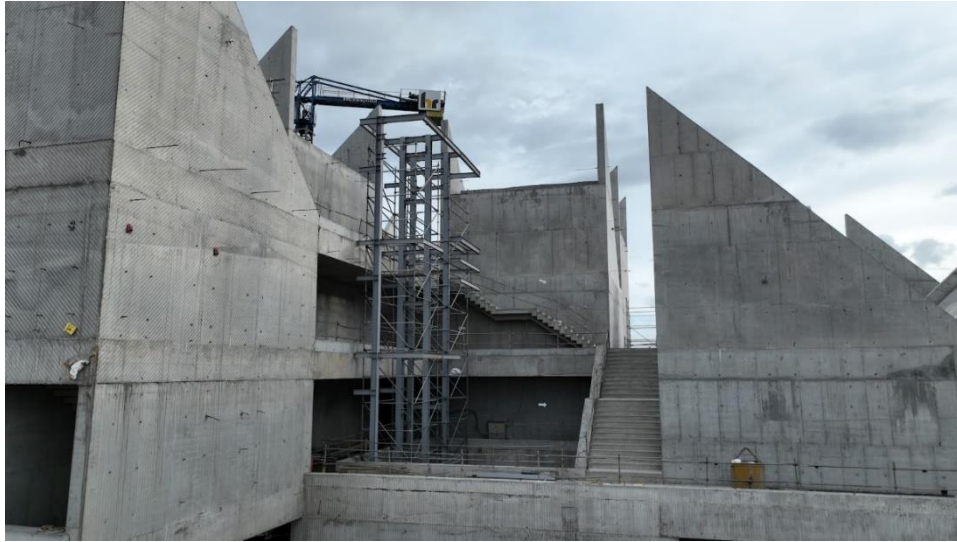
Instalación de estructura metálica núcleo oriental de ascensores.
