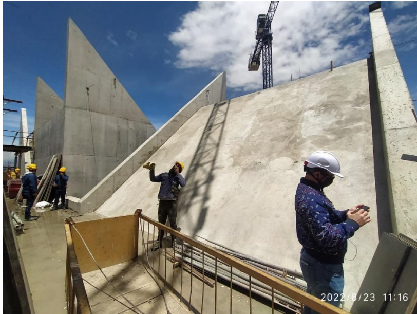
Avance presentado del armado de acero, formaleta y vaciado de concreto para placas inclinadas de los picos de cubierta.
