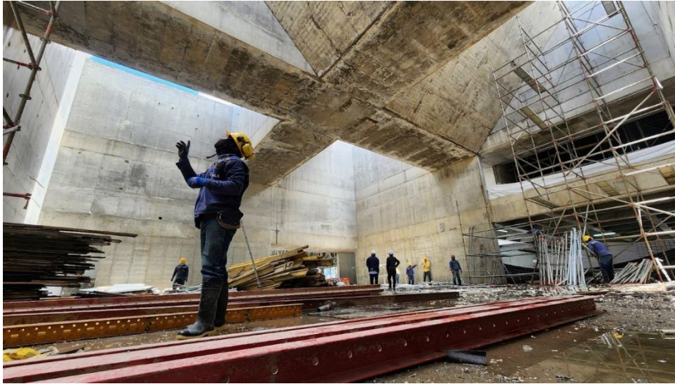
Perspectiva descimbrada de sala 1 localizada en el segundo piso.
