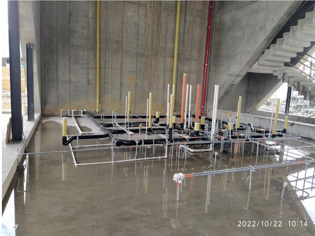
Avance de instalaciones técnicas.
