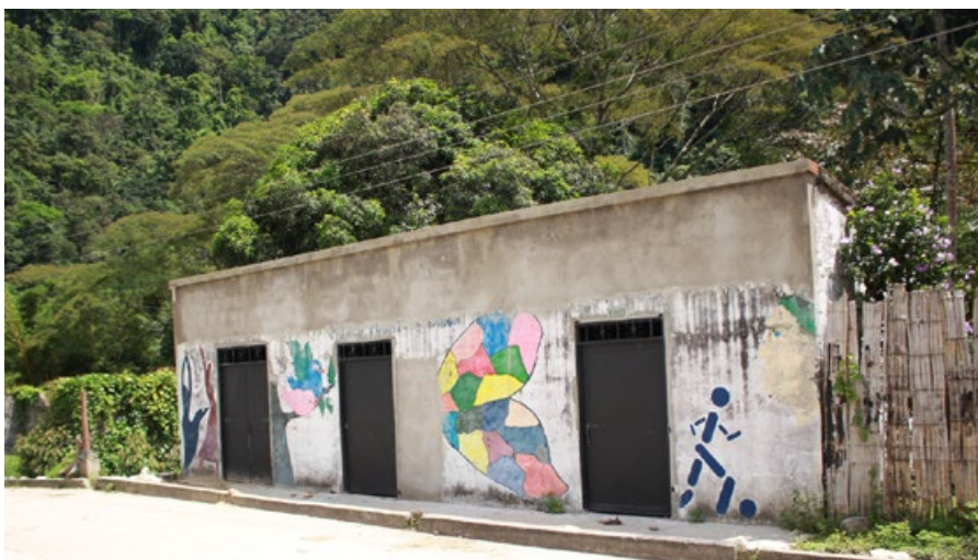
Casa en proceso de restauración. Fotografía para el CNMH de Daniel Sarmiento Gómez, 2020.
