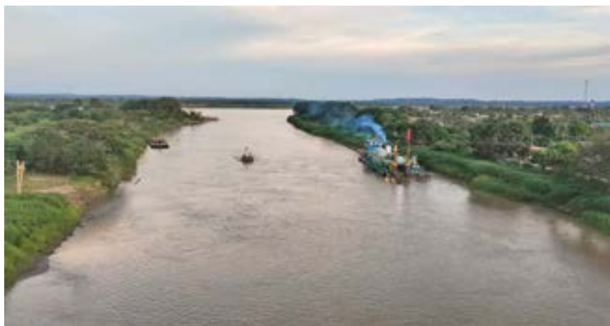
Figura 7. Vista del río Magdalena (fondo) y el Canal del Dique en el puente de Calamar que une los departamentos de Atlántico y Bolívar.
