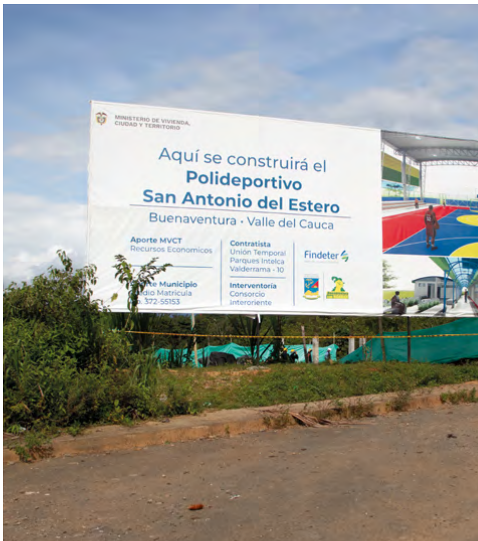
Obra del Polideportivo San Antonio del Estero. Archivo del Movimiento Social Paro Cívico de Buenaventura.
